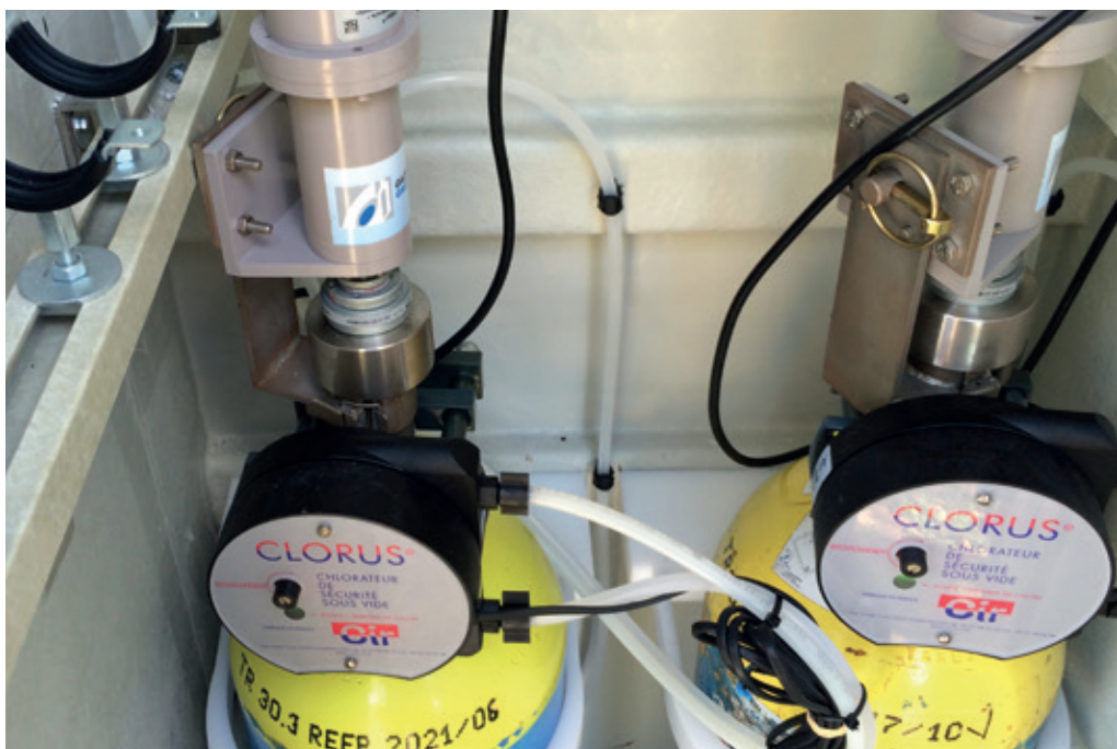
Commercialisé par la société, l'actionneur Actech est un système de fermeture automatique de bouteilles de chlore ayant pour objectif de diminuer la durée d'une fuite de chlore lors de l'utilisation d'une bouteille.
