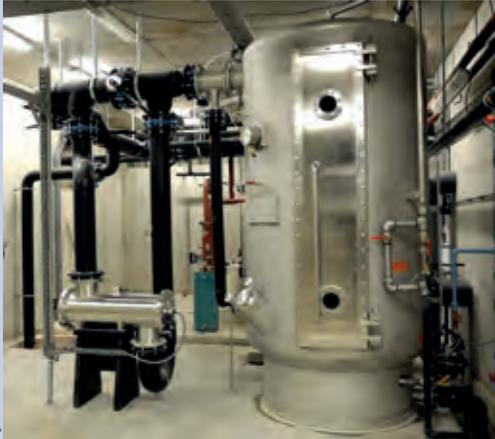
utilise un mélange d'eau et d'air injecté entre les plateaux pour augmenter la durée de vie des toiles, l'opération étant entièrement automatisée. En effet, sur ce type de filtration, il n'y a pas lieu de laisser couler l'eau au réseau en surveillant son aspect afin de savoir si le filtre est propre. Le décolma-
