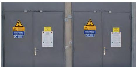
Les bouteilles de chlore doivent être stockées dans des locaux, indépendants, réservés à cet usage unique et dont la porte d'accès donne sur l'extérieur. Ce sont des règles d'implantation qui permettent une intégration facile dans le projet architectural du programme car elle ne nécessite que peu d'espace au sol (idéalement armoire ou niche de 80 cm de profondeur).
